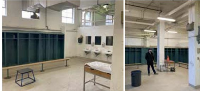
Vestiários Existentes no Primeiro Andar
