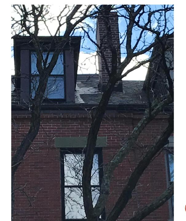
**OVERLAPPING** SHINGLES ON TOP OF SLATE IN FRONT OF THE RIGHT CHIMNEY
