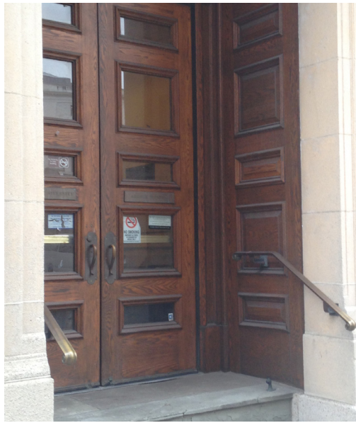
EXISTING DOOR PHOTO
